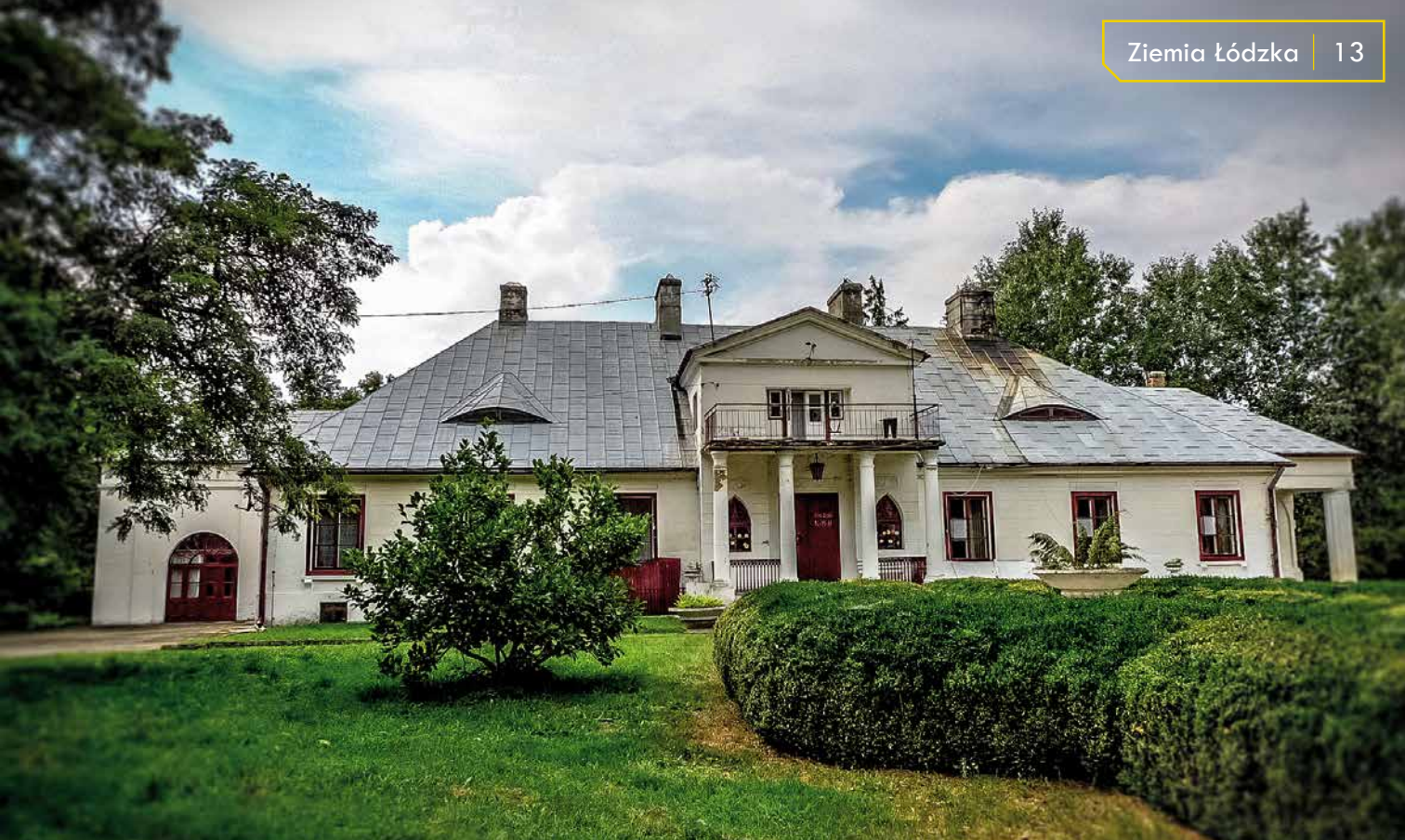
■ Dwór w Rychłociach elewacja frontowa
