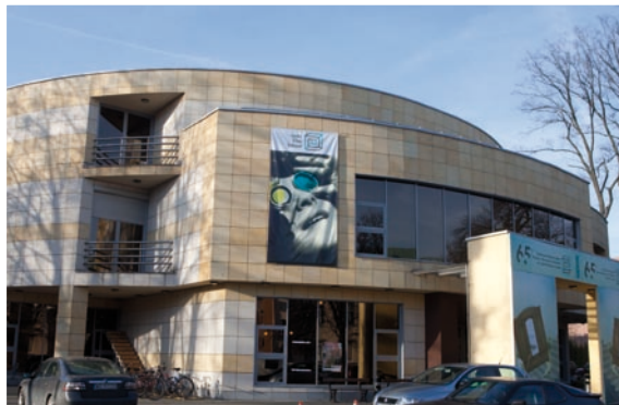
Powyżej: nowoczesna hala zdjęciowa i studio telewizyjne. Po lewej: Centrum Nowych Mediów
