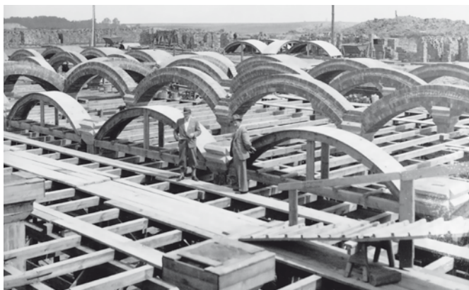
Budowa zbiornika wodnego na Stokach
