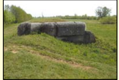
Jeden ze schronów bojowych na linii Warty
