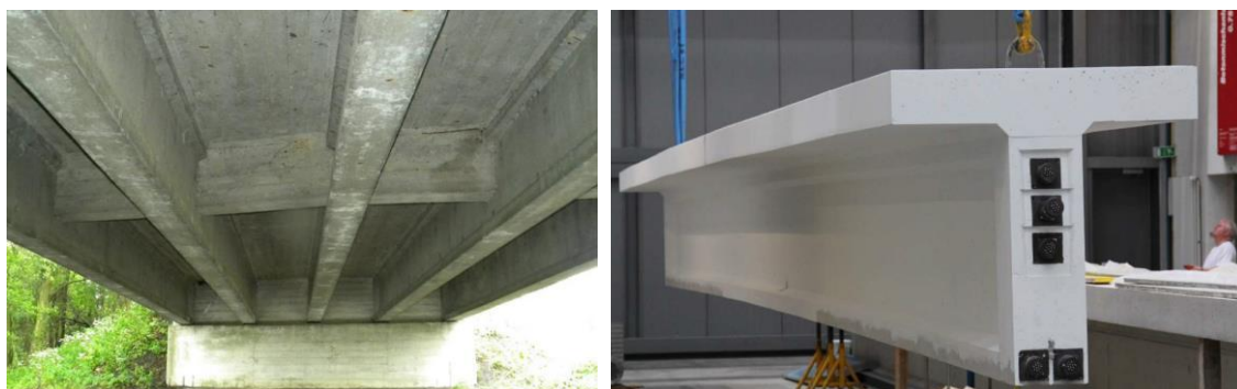
Rysunek.1. Konstrukcja mostu przeznaczonego do wzmocnienia (strona lewa) oraz jeden z zrekonstruowanych w laboratorium dźwigarów (strona prawa)
