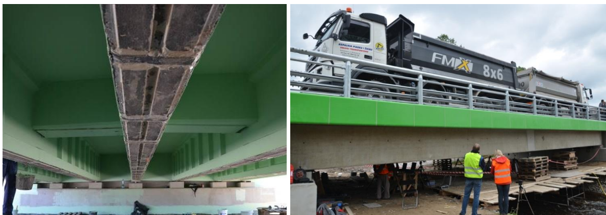
Rysunek.3. Dźwigar mostu wzmocniony taśmami CFRP (strona lewa) oraz próba obciążeniowa po zakończeniu wzmocnienia i modernizacji mostu (strona prawa).
