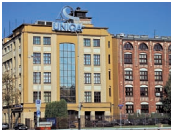
Siedziba UNIQA Towarzystwa Ubezpieczeń S.A. (dawna fabryka H. Mittkego)
