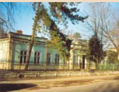
5. ul. Żeromskiego — kompleks budynków szpitalnych z 1904 r. powstał z inicjatywy Oskara Kindlera. W 1911 r. szpital posiadał 45 łóżek.
