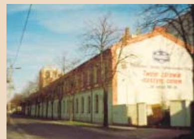
12. ul. Piłsudskiego — budynki fabryczne z końca XIX w. Spółki Schweikerta i Frelicha, którzy produkowali tu barwniki do włókna i garbniki do skór; obecnie „Polfa”.
