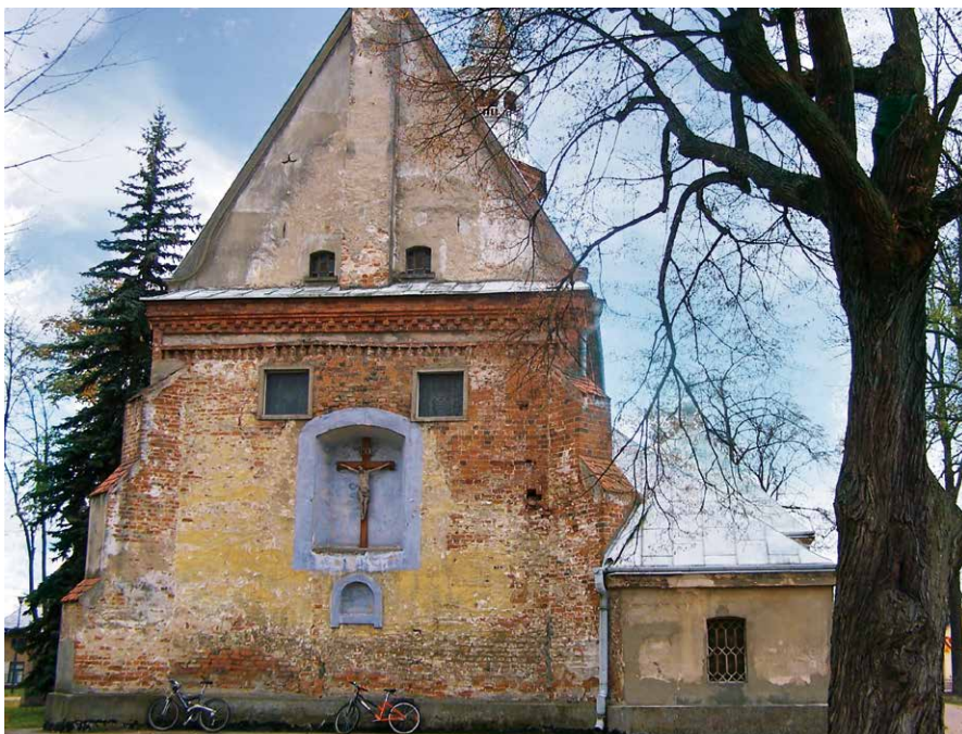
■ Kościół w Buczku koło Łasku, zbudowany w głównym zrębie ok. poł. XV w.
